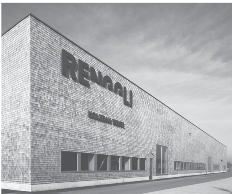
Bild: Werk der Renggli AG in Schötz; Bilder Titelseite: Überbauung Freilager in Zürich und Mehrfamilienhaus in Oberkirch
