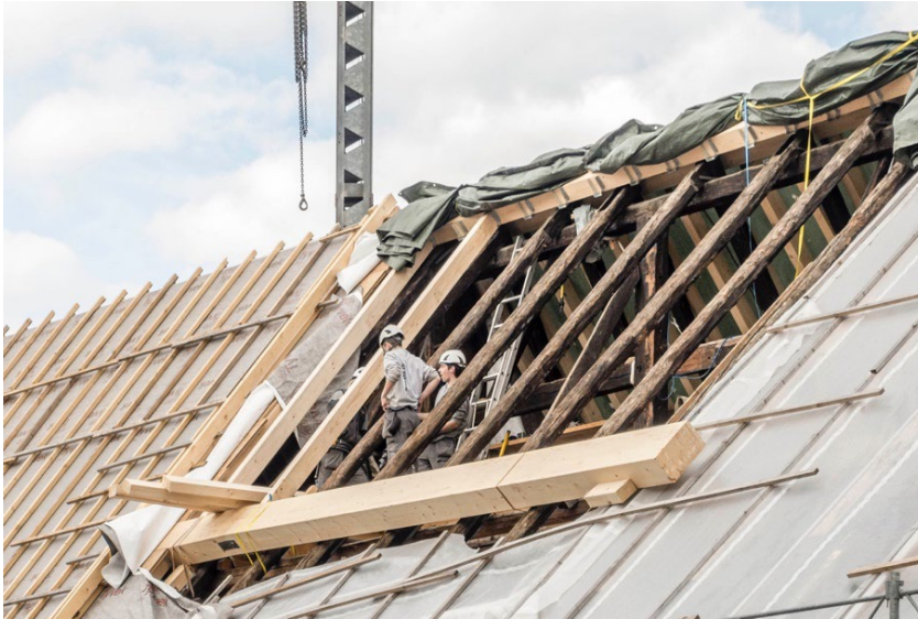
Abb. Aufbringen der adaptiven äusseren Pfetten und Rafenkonstruktion durch den Holzbauer
