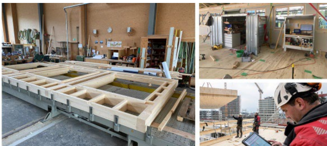
Abb. 14 Die Holzbauer arbeiteten konsequent ab elektronischen Lesegeräten
