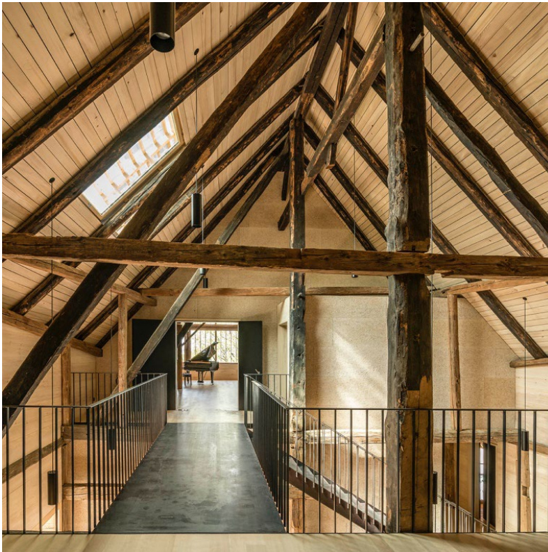
Abb. Blickachse im Dach, neue Treppe zwischen Hochstudkonstruktion
