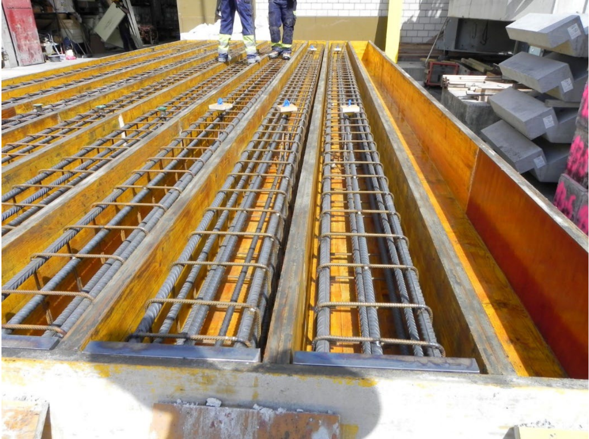
Abb.2 Armierung FT-Pfähle
