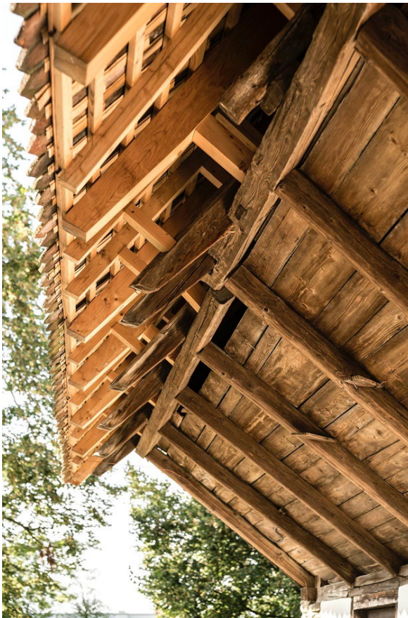
Abb. Vordach Traufseitig aufgeständert über alten Rafen, sowie Konstruktionsschnitt
