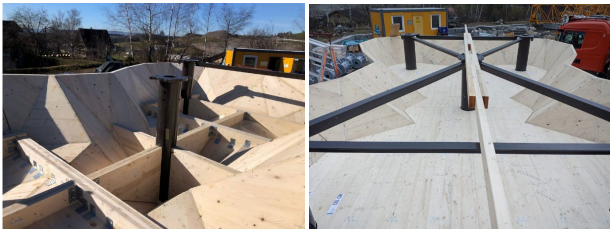
Abb. Zusammenbau Schalensegmente in Sihlbrugg
