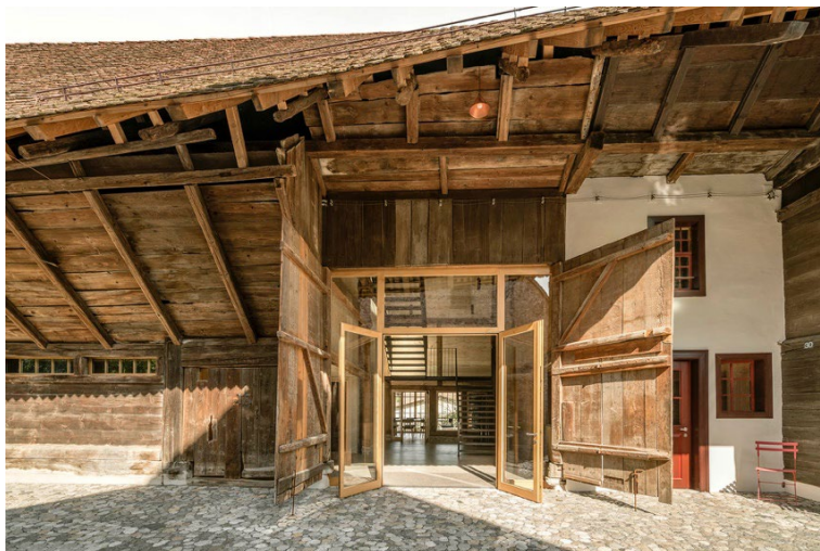
Abb. Eingang ins Tenn, darüber die bestehenden und neuen Aufständungen der Rafen
