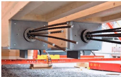
Abb. 6: Verankerung der Vorspannlitzen im Unterzug (Foto: Künzli Holz AG)
