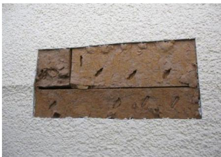
Abb. 33 Schlecht ausgeführte Bauteilfuge mit Quetschfalte
