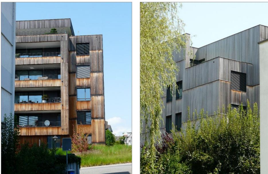
Abb. 7 Einfluss der (unregelmässigen) Bewitterung auf das Vergrauen bei Holzfassaden; Mehrfamilienhaus Steinhausen; Scheitlin Syfrig Architekten, Luzern (Baujahr 2006; Fotos 2012; HP. Kolb; links: Süd-West-Fassade, rechts: Nord-Ost-Fassade)
