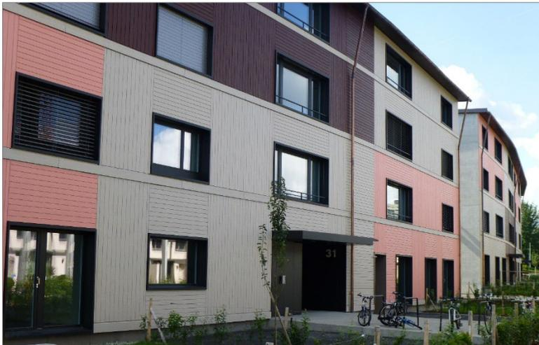
Abb. 8 *Holzfassade mit Oberflächenbehandlung (komplette Applizierung im Werk)
