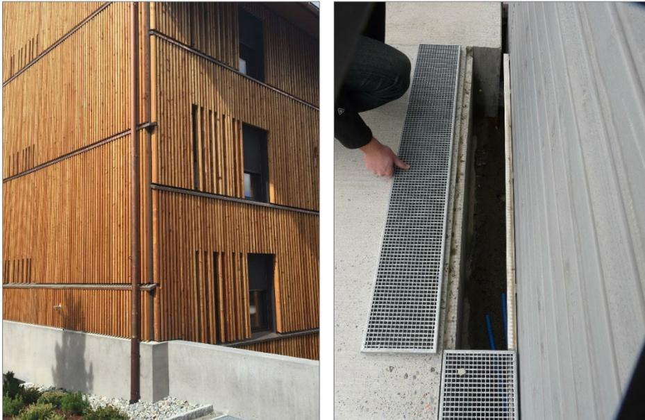
Abb. 10 Sockelausbildung mit genügend Abstand im Spritzwasserbereich; Brandschutzmassnahme als Witterungsschutz
