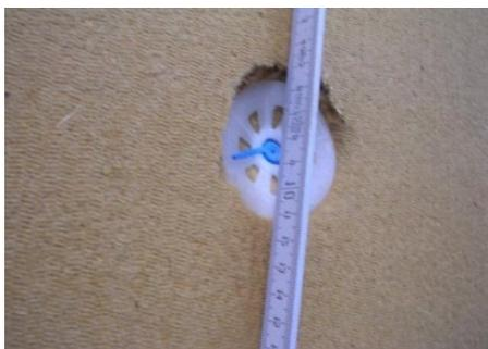
Abb. 35 Zu tief eingebrachter Tellerdübel
