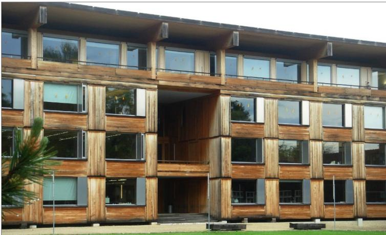
Abb. 5 Trotz grossem Vordach ist die Holzfassade in Eiche nicht vor Witterung, insbesondere Schlagregen, geschützt;
