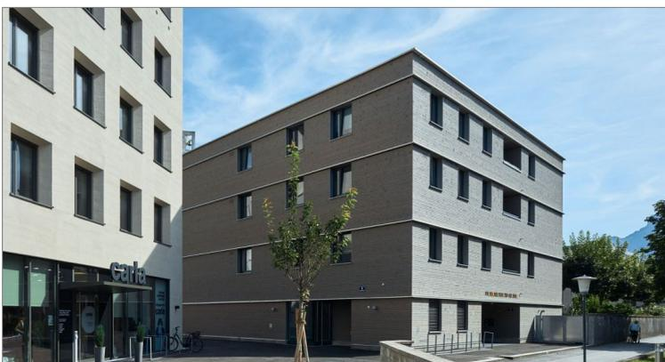
Abb. 6 Gebäude mit kleinem Vordach aber mit Schutzmassnahmen in der Fassade (in Kombination mit den Brandschutzmassnahmen pro Geschoss)
